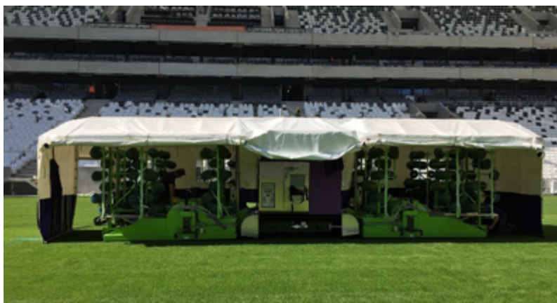
Rys. 17 Montaż zszywanej trawy hybrydowej
