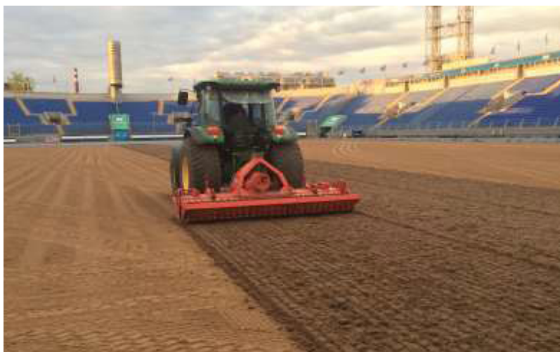
Rys. 15 Montaż wzmocnionej warstwy korzeniowej
